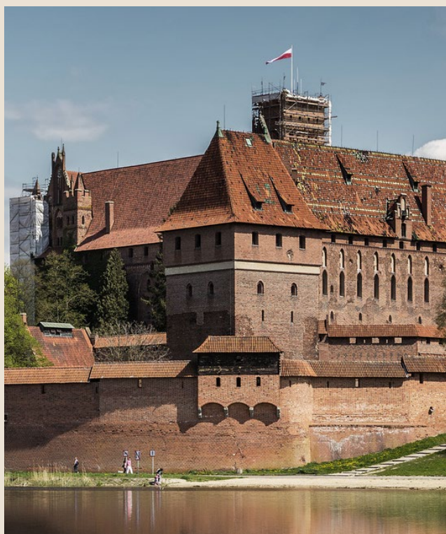
Pałac Wielkich Mistrzów w Malborku – prace renowacyjne z użyciem pełnej technologii zapraw wapienno-trassowych firmy Hufgard-Optolith
