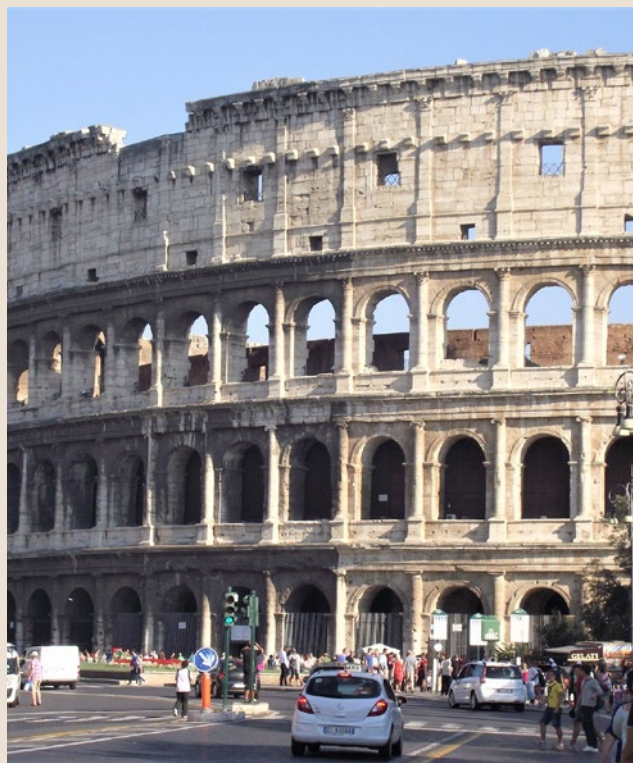
Colosseum jest jednym z najlepiej zachowanych obiektów architektury starożytnej. Jest to też znakomity przykład wykorzystania zapraw hydraulicznych opartych na wapnie z dodatkiem pucolany.
