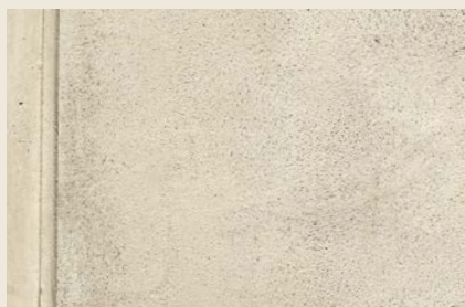
Pałac Poznańskiego w Łodzi - przykład zastosowania strukturalnej farby Optosan Silisan Grob z późniejszym laserunkiem, imitującej drobnoziarnisty, barwiony tynk.
