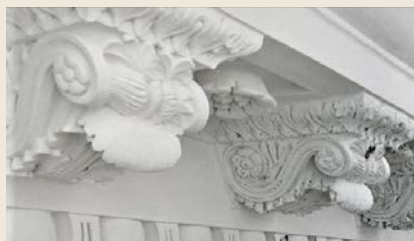
Przekrycie rys skurczowych na sztukaterii z użyciem Optosan RissGrund na całej powierzchni. Po prawej w oddali element już po oszlifowaniu z nadmiarów gruntu.
