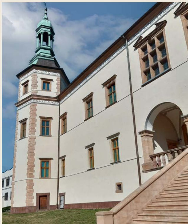
Barokowy Pałac Biskupów Krakowskich w Kielcach. Indywidualnie przygotowane farby zolno-krzemianowe Silisan Plus w połączeniu ze specjalnym medium Fixativ do dekoracji laserunkowych.
