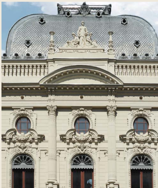
Pałac Poznańskiego w Łodzi - przykład zastosowania strukturalnej farby Optosan Silisan Grob z późniejszym laserunkiem, imitującej drobnoziarnisty, barwiony tynk.
