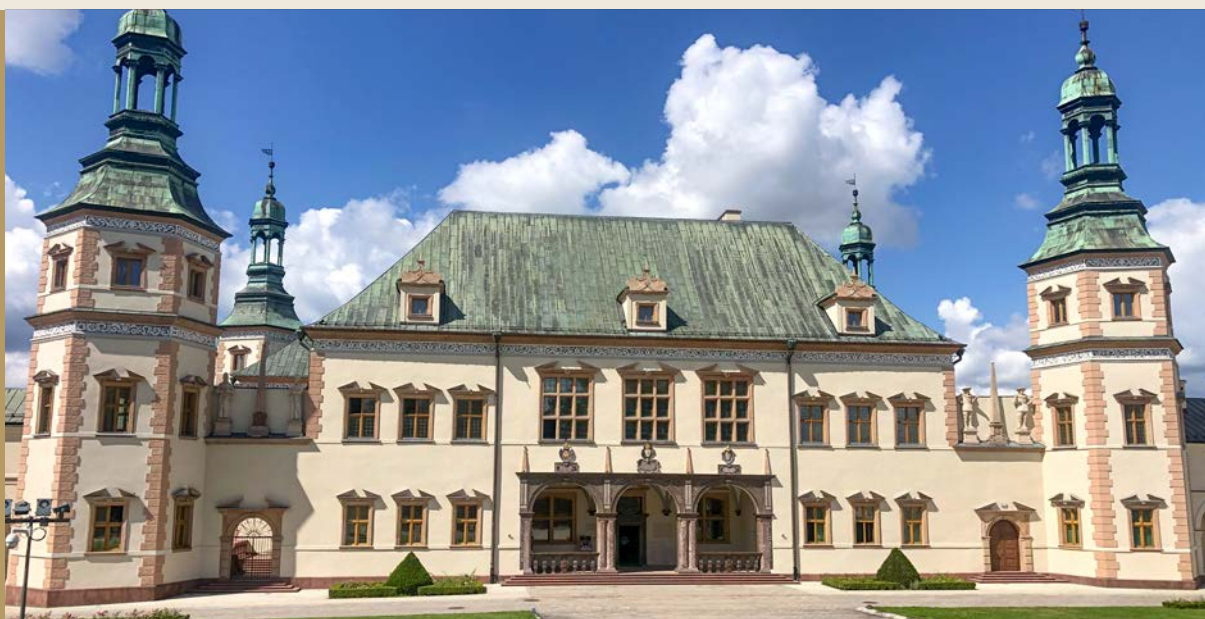
Elewacja barokowego Pałacu Biskupów Krakowskich w Kielcach – wysokodyfuzyjna i hydrofobowa mineralna farba Optosan Silisan Plus.
