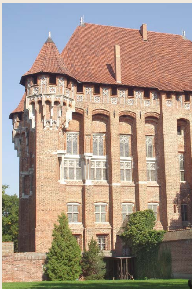
Pałac Wielkich Mistrzów na zamku krzyżackim w Malborku. Przykład zastosowania kompleksowej technologii zapraw wapienno-trassowych Optosan.
