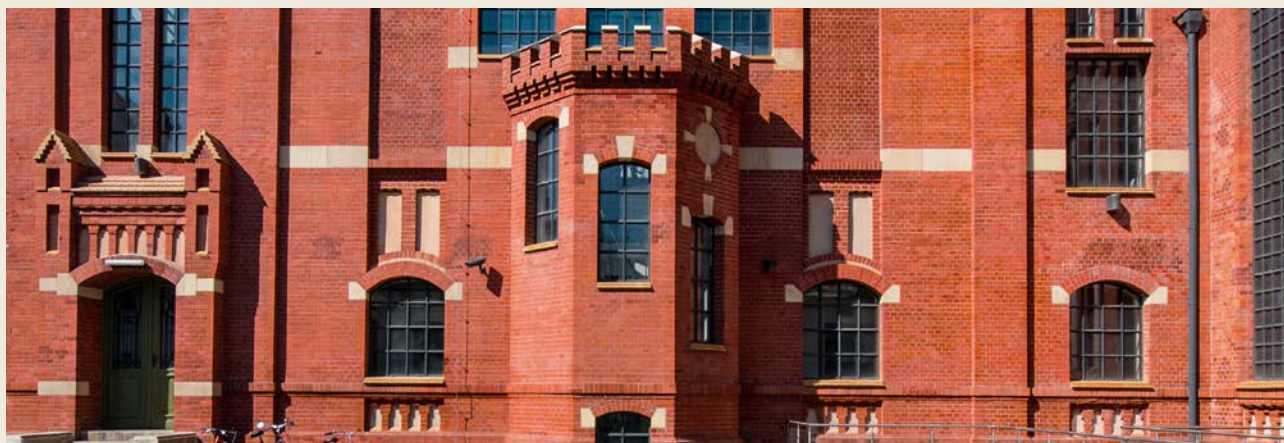
Zespół zabytkowych budynków najstarszej elektrowni w Łodzi z 1907 r. Hydrofobizacja elewacji Hydrosilan.
