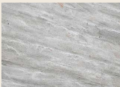
RenoPutz specjal nałożony bezpośrednio na podłoże w sposób malarski jako tzw. „tynek z pędzla”
