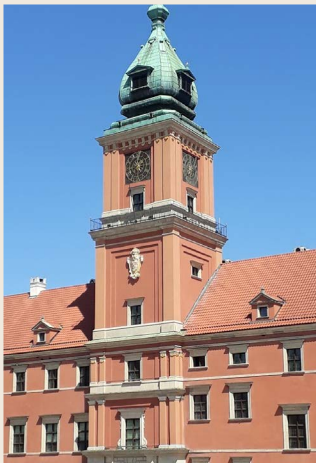
Zamek królewski w Warszawie – przykład zastosowania kompleksowej technologii wypraw tynkarskich Optosan: wapienno-trassowe tynki podkładowe i cienkowarstwowe barwione w masie oraz tynki renowacyjne WTA.
