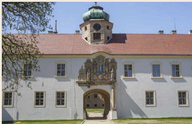
Zamek w Głogówku – samodzielnie przygotowane na placu budowy tynki na bazie spoiw z trassem Optosan TrassKalk i TrassZement; tańszy wariant przy bardzo dużej powierzchni prac.
