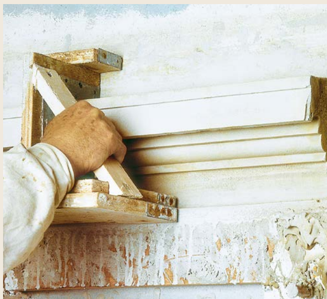
Budowa profilowanego gzymsu przy użyciu zaprawy Optosan Stucko Fein ciągnionej na saniach sztukatorskich.
