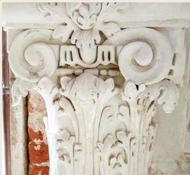
Rekonstrukcja z ręki ozdobnej głowicy z użyciem zaprawy modelarskiej Optosan NSR.
