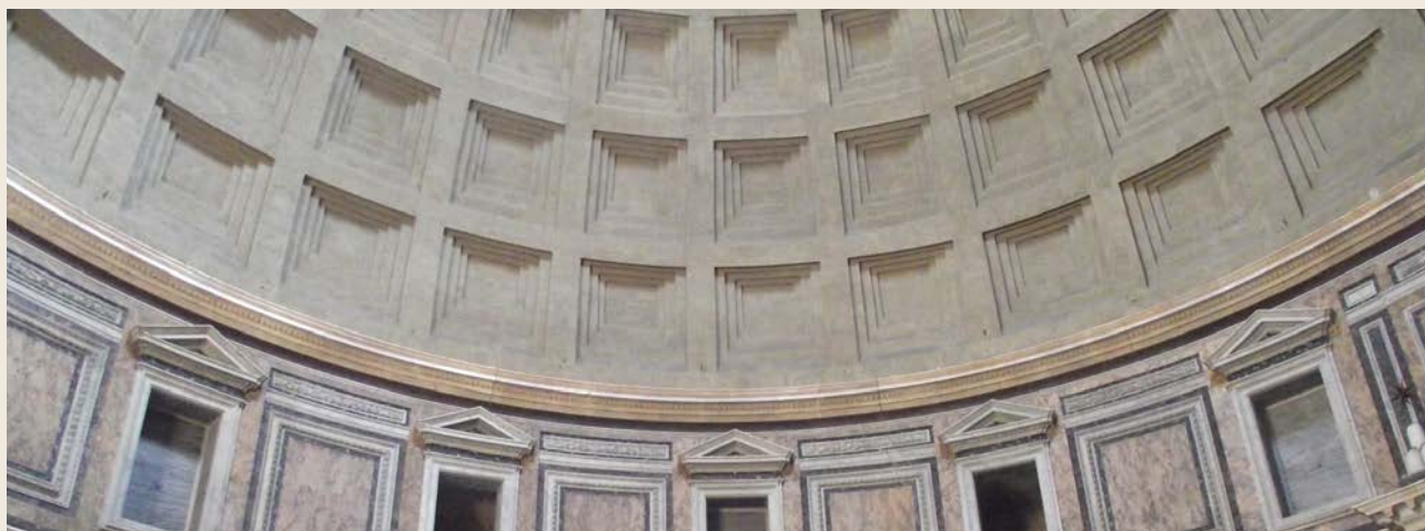
Panteon w Rzymie jest najlepiej zachowanym zabytkiem Starożytności. Jego imponująca kopuła o średnicy większej niż kopuła Bazyliki św. Piotra w Watykanie mogła powstać dzięki zastosowaniu zaprawy wiążącej hydraulicznie opartej na mieszaninie wapna i tufu wulkanicznego tzw. „rzymskiego betonu”.
