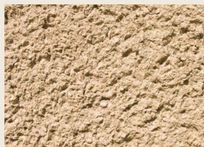
KratzPutz o strukturze cykliny barwiony w masie z dodatkiem miki
